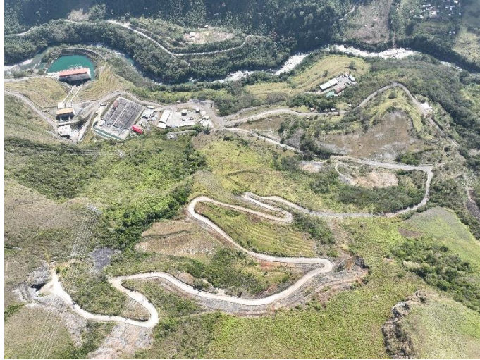
Foto 2.- Áreas sin uso colindantes a SE Eléctrica y oficinas
